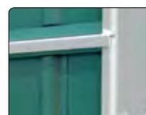
Le cadre robuste en 20/10e dispose aussi, autour des portes, d'un système anti-effraction en empêchant l'introduction d'outils
